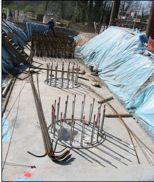
Figure 4 : vue de pieux recépés qui attendent la semelle de liaison
