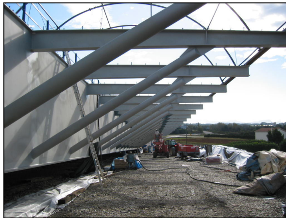
Figure 5: L'assemblage du tablier
