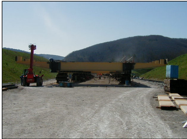
Figure 3 : vue de la plateforme qui sera la future voie
